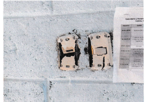
Foto 4: Apagadores deteriorados.
