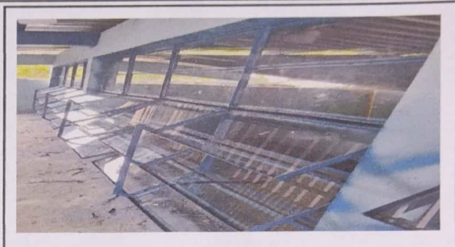
Foto 2: Finalización de Vidrios
