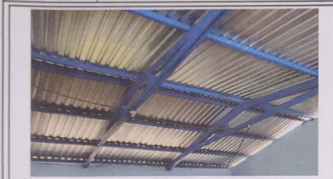
Foto1: Cubierta de Lámina
