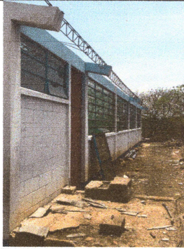
Foto 1: Reconstrucción de canales.
