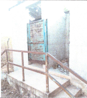
Foto 5: Mantenimiento de puertas.
