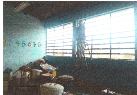
Foto 6: Pintura de interior.
