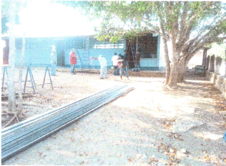
Foto 3: Reconstrucción de techo.
