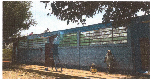
Foto 2: Recinstrucción de estructura metálica.
