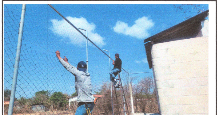
Foto 2: REPARACION DE MALLA
