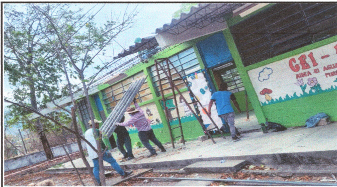
Foto 3: COLOCADO DE LAMINA NUEVA
