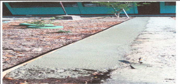
Foto 6: REPARACION DE LOSA DAÑADA
