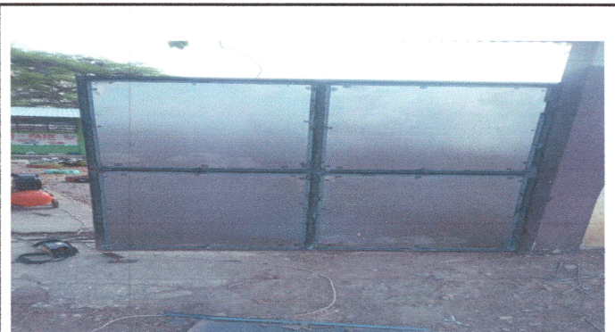
Foto 4: REPARACIÓN DEL PORTON ENTRADA
