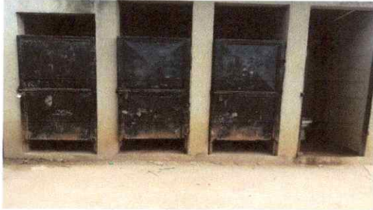
Foto7: REPARACION DE DRENAJE Y AGUA POTABLE PARA SANITARIOS
