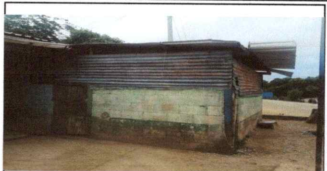
Foto 2: SUSTITUCIÓN DE ESTRUCTURA DE EL TECHO DEL AULA
