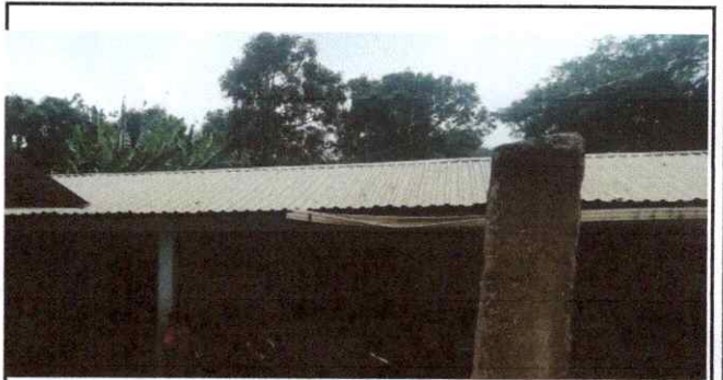
Foto 4: SUSTITUCIÓN DE CANALES Y BAJAS DE AGUAS PLUVIALES
