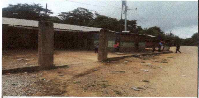
Foto 8: SUSTITUCIÓN DE CERCO PERIMETRAL
