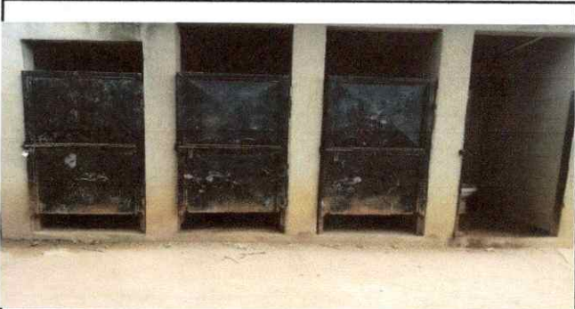
Foto 3: SUSTITUCIÓN Y REPARACIÓN DE PUERTAS DE AREA DE BAÑOS
