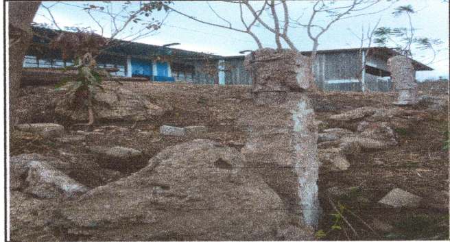
Foto 2: Reparacion de Muro de Contencion
