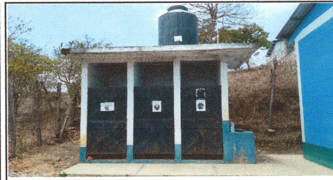
Foto 5: Mantenimiento de tuberias de aguas servidas
