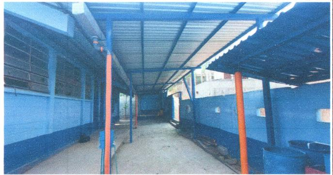
Foto 4: Estructura metalica y lamina troquelada ya instaladas.
