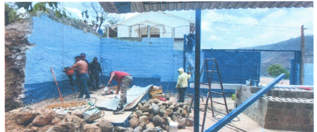
Foto 2: Perforación de agujeros para instalación de estructura metálica.
