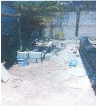
Foto 1: Diseño e instalación del jardín de area verde. Y muro perimetral No.2
