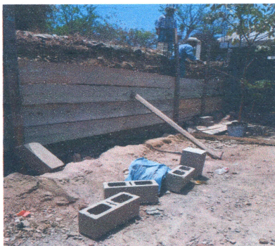
Foto 3 Fundición de concreto con piedras para el muro de contención.
