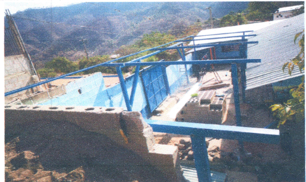
Foto 4: Estructura instalada para colocación de lamina troquelada.
