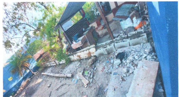
Foto 6: Fundiendo viga de humedad para la pared del muro perimetral No.2.
