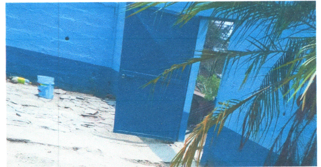
Foto: 6 Reparación de Loza de patio exterior.
