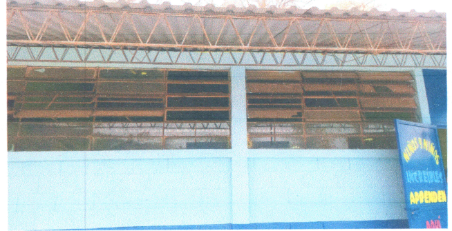
FOTO 2: Mantenimiento y restauración de ventanales.
