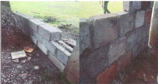
Foto 5: MURO PERIMETRAL DE BLOCK
