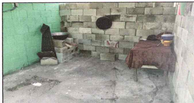
Foto 5: SE OBSERVA AREA DE COCINA
