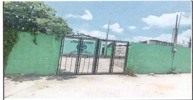
Foto 6: ENTRADA PRINCIPAL DE LA ESCUELA
