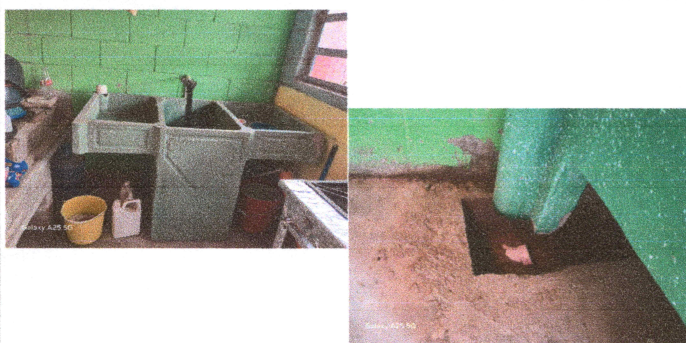
Foto 5: REPARACION DE RED DE DRENAJES Y RED DE AGUA POTABLE
