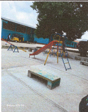
Foto 1: LOSA DE PATIO
