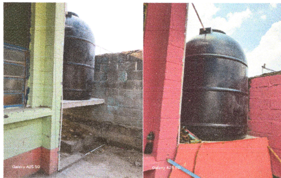
Foto 2: REPARACION Y MANTENIMIENTO DE CISTERNAS/ DEPOSITO DE AGUA
