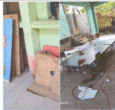
Foto 4: MANTENIMIENTO A PORTONES
