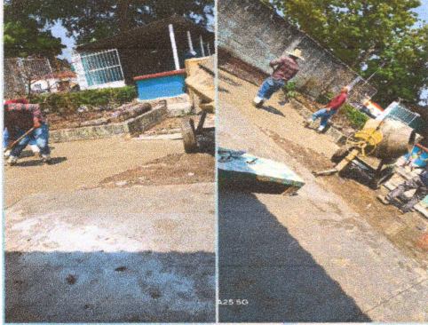
Foto1: LOSA DE PATIO
