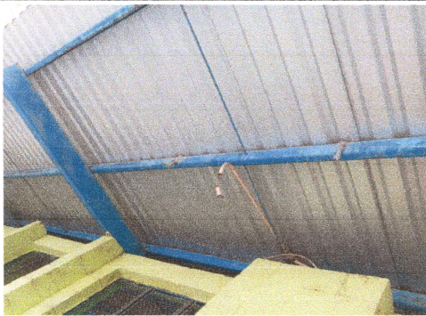
Foto: 5 AREA A TRABAJAR REPARACION SISTEMA ELECTRICO
