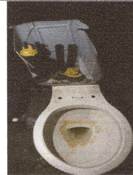
Foto: 6 AREA A TRABAJAR SERVICIOS SANITARIOS Y ACCESORIOS
