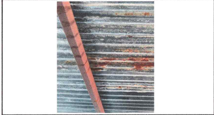
Foto 2: Sustitución de estructura de techo.
