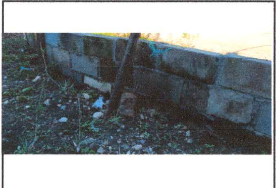
Foto 10: Sustrucción cerco y muro perimetral.
