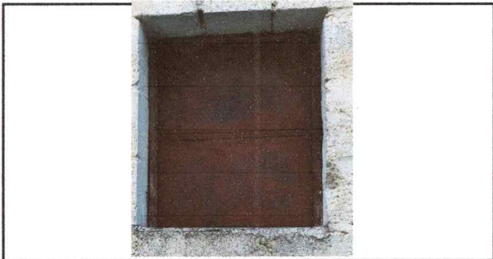
Foto 5: Sustitución ventana de cocina.
