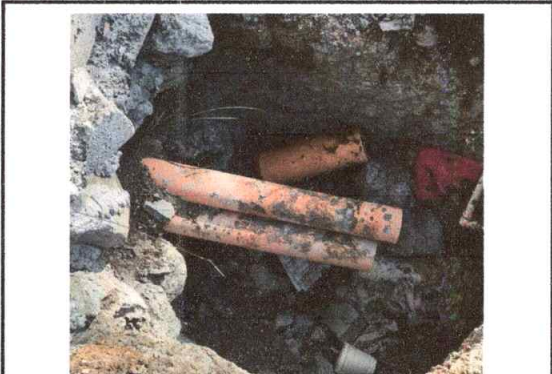
Foto 9: Reparación de Drenaje y red de agua (sustrucción).
