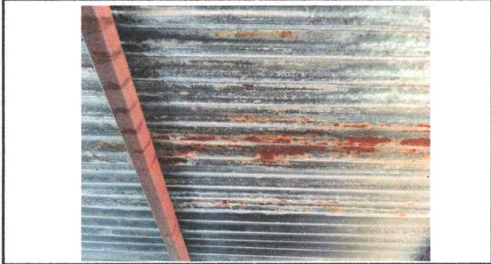
Foto 1: Sustitución de cubierta de lámina.
