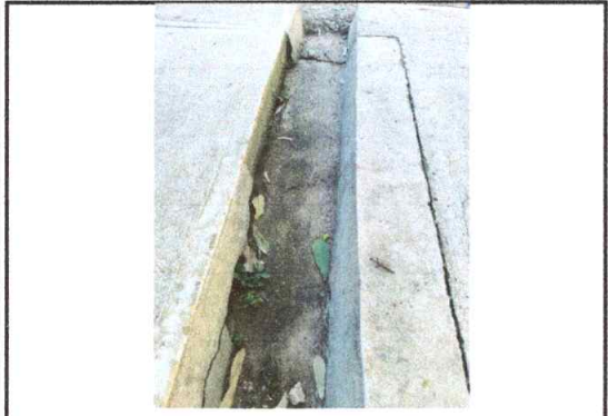
Foto 8: sustitución cuneta de concreto.
