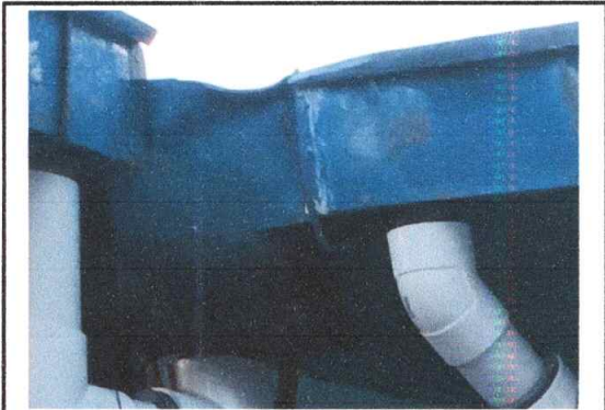
Foto 7: Sustrucción de Canales y bajadas de agua.
