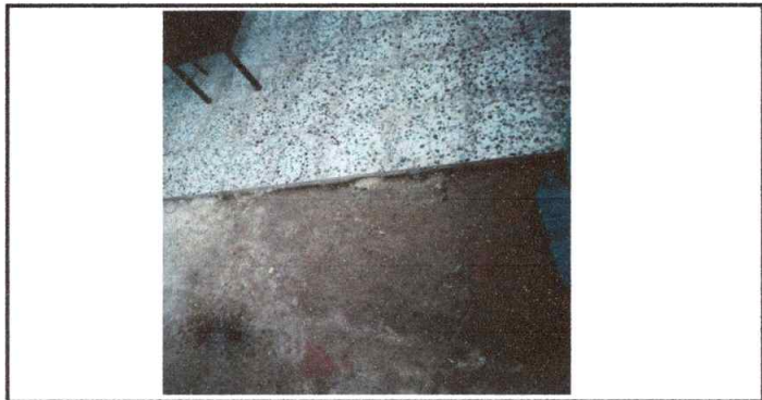
Foto 6: Sustitución piso de granito en área de cocina.
