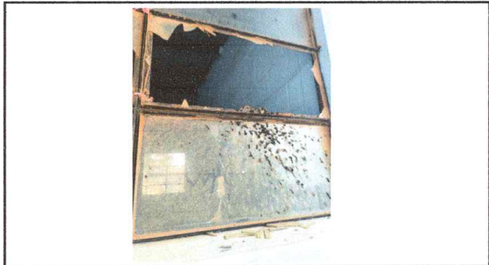
Foto 4: Sustitución de ventana de aula.
