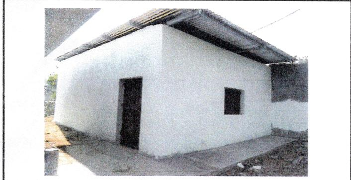
Foto 1: Reparación de área de cocina: puerta, ventana, estufas, pilas, chimeneas repello estructura, techo
