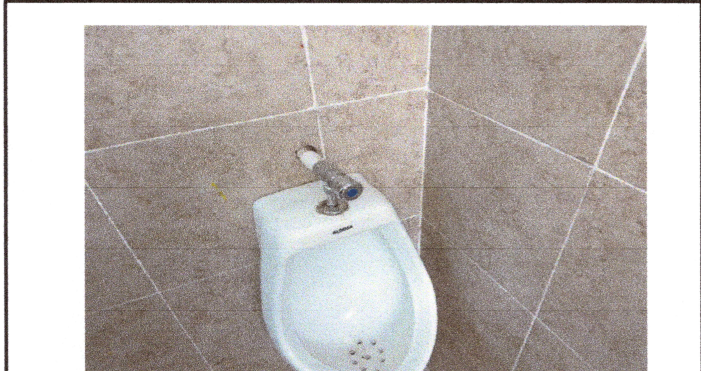
Foto 3: Reparación de baños y sus accesorios
