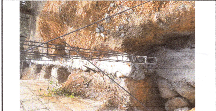
Foto 2: Reparación de muro perimetral
