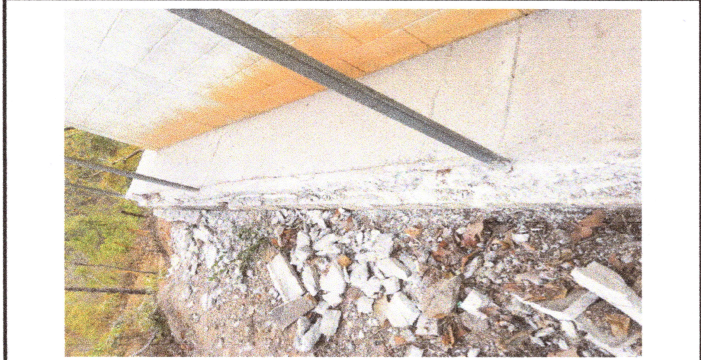
Foto 1: Reparación de cerco perimetral
