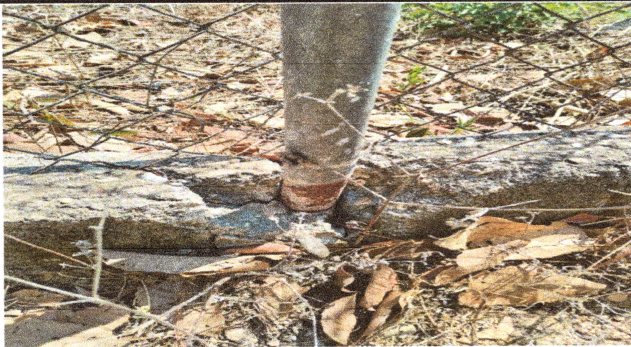
Foto: 5 Reparacion de cerco perimetral
