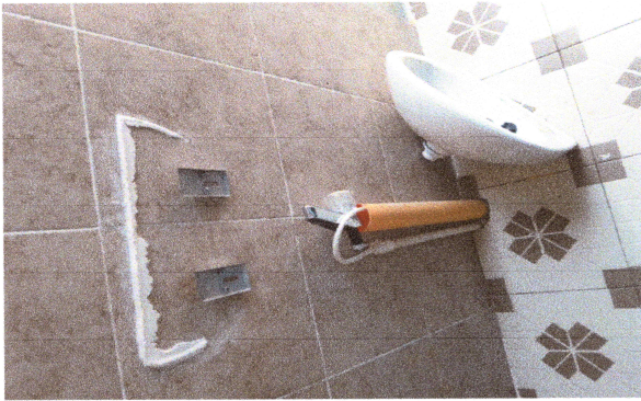
Foto3: Reparación de sanitarios y sus accesorios
