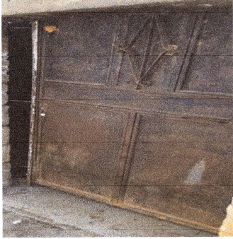
Foto1: Reparación de áreas de cocina: puertas, ventanas, estufas, pilas, chimineas, repello, piso, estructura, techo
