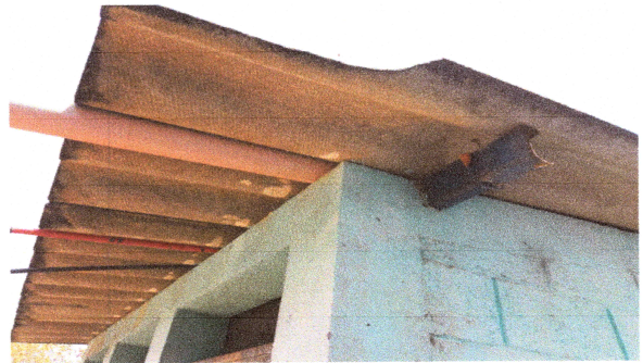
Foto: 6 Reparación de techo (baños)
