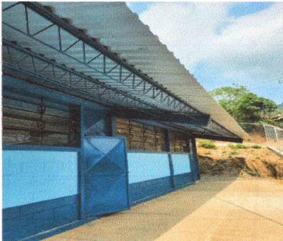
Foto 3: finalización de pintura en exterior y puertas
