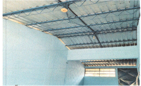
Foto 2: colocacion de pintura en interior de las aulas
