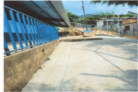
Foto 4: Finalización de plancha de concreto
