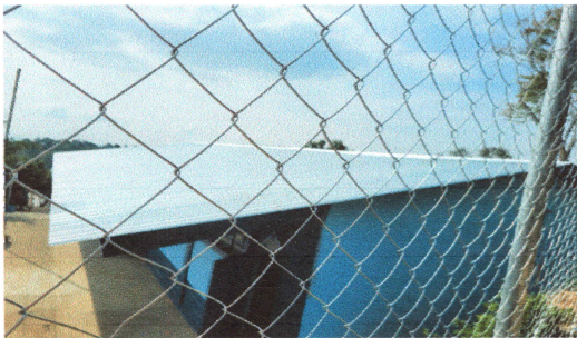
Foto 5: colocacion de maya finalizado
