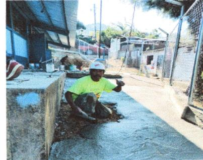
Foto 6: fundición de plancha de concreto
