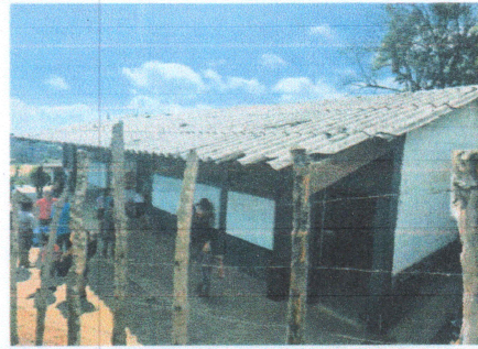
FOTO 2: PINTURA EN MUROS INTERIOR Y EXTERIOR
