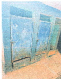
Foto: 5 REMOZAMIENTO DE PUERTAS
