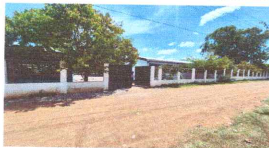
Foto 6: fotografia exterior parte frontal del establecimiento
