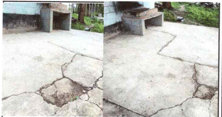
Foto4: sustitución de losa de patio, fundición y acabado area de cocina
