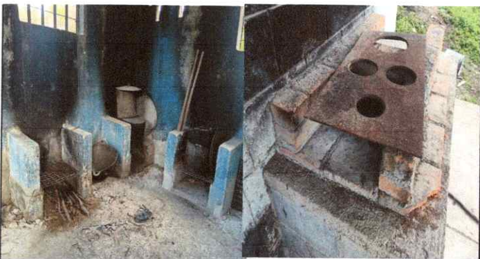
Foto: 5 reparación, sustitución en area de cocina, estufa rural,
