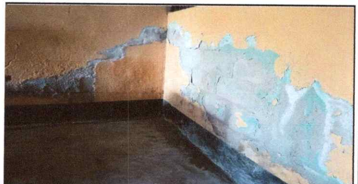
Foto: 6 repello de paredes interior y exterior area de cocina y en partes dañadas
