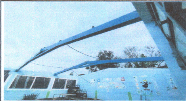
Foto 1: Sumistro e instalación de lamina troquelada calibre 26
