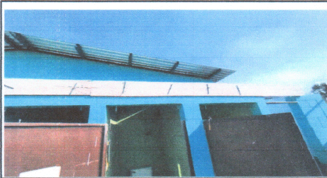
Foto 3: Instalación de puertas
