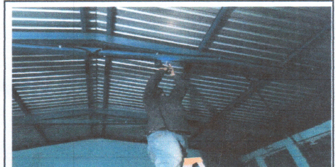
Foto 6: Reparación de sistema electrico en modulo 1 y 2
