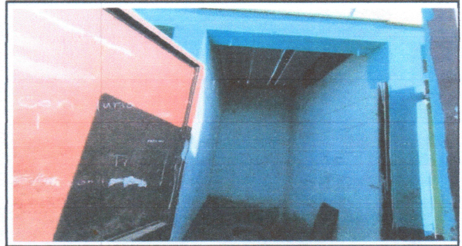
Foto 4: Reparación de puertas
