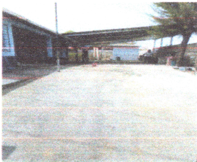
Foto 3: Flosa de patio terminada
