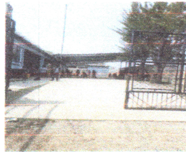
Foto 4: losa de patio terminada
