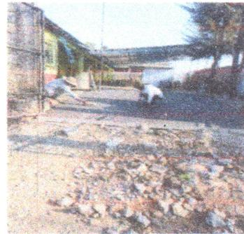
Foto 4: Fundicion losa de patio
