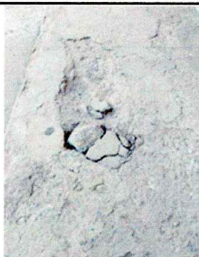
Foto 5: SE OBSERVA PISO DE CONCRETO EN MAL ESTADO (SUSTITUCIÓN)
