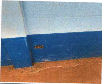
Foto 3: Reparación sistema eléctrico
