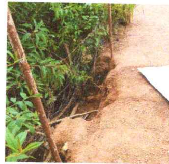
Foto 6: Cerco o muro perimetral
