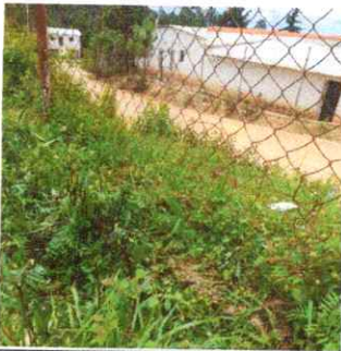
Foto 5: Cerco o muro perimetral
