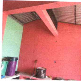
Foto 4: Reparación sistema eléctrico
