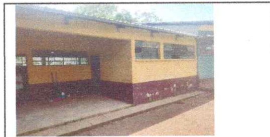
Foto 5: PINTURA EN MUROS DE AULAS INTERIOR Y EXTERIOR
