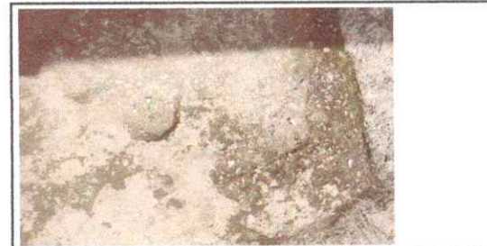
Foto 6: LOSA DE PATIO
