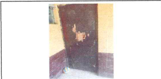
Foto 1: SUSTITUCION DE PUERTA
