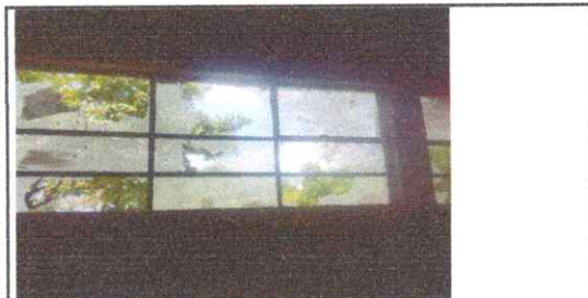
Foto 3: SUSTITUCION DE VIDRIOS DE VENTANAS EN AULAS
