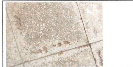
Foto 4: SUSTITUCION DE PISOS EN AREA DE AULAS
