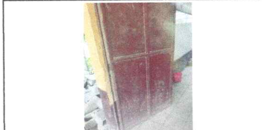
Foto 2: REPARACION DE PUERTA
