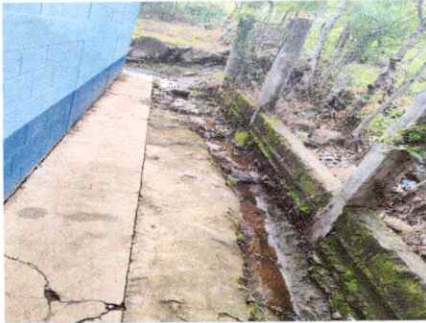
Foto 3: repacion y mantenimiento de cuneta
