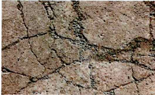
Foto1: Sustitución losa de patio
