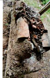
Foto 2: Sustitución de area de cocina (estufa rural)
