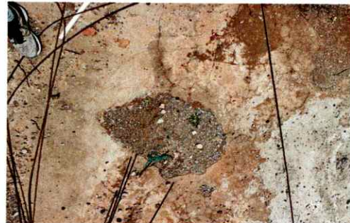
Foto 4: Sustitución de piso
