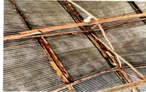
Foto 2: Estructura de techo
