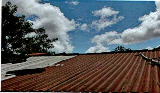
Foto 1: Cubierta de lámina
