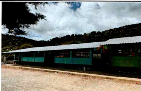
Foto 5: Pintura en muros exterior
