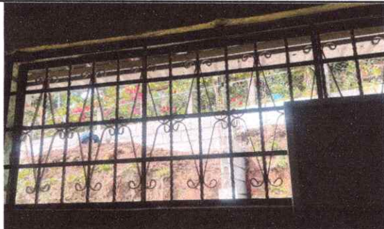
Foto 5: Sustitución de vidrios.
