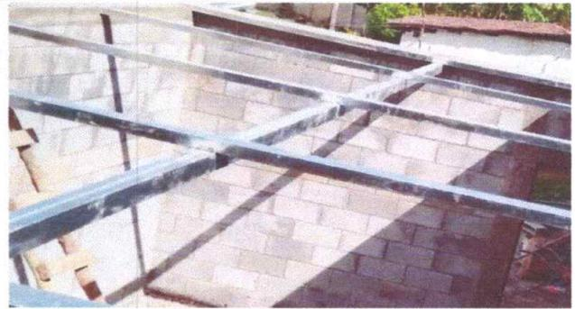
Foto 2: Estructura de techo reparado
