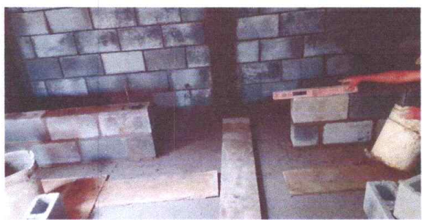
Foto 6: Reparación de áreas de cocina
