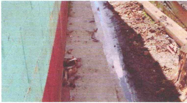
Foto 3: Reparación de cuneta
