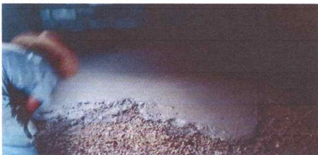
Foto 5: Fundición de piso
