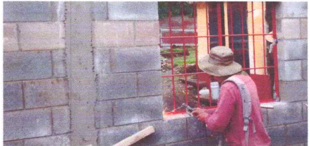
Foto 4: Sustitución de balcón
