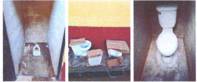
Foto 2: Sustitución de baños sanitarios
