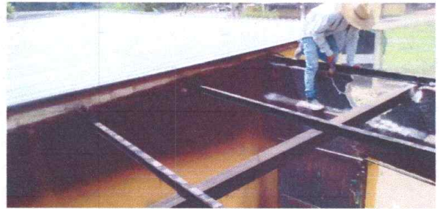
Foto 2: Cambio de estructura de techo
