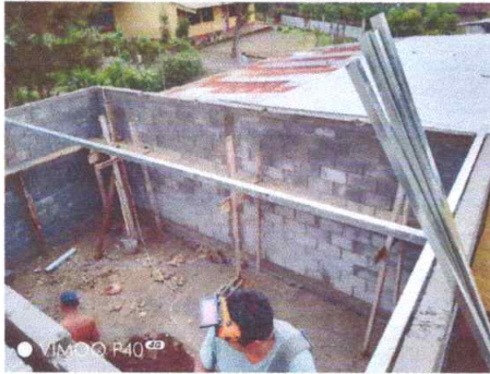
Foto 1: Cambio de techo
