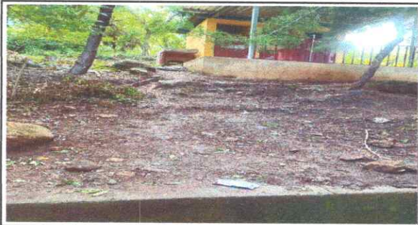
Foto 9: Mantenimiento de gradas para sanitarios.
