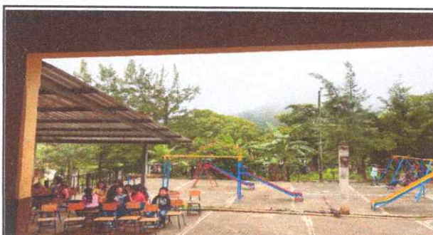
Foto 4: Complemento de estructura en galera principal.
