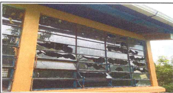
Foto 5: Reposición de vidrios dañados.
