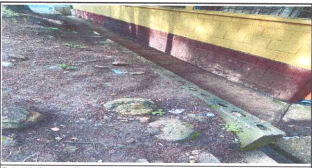
Foto 11: Reparación de muro de contención.
