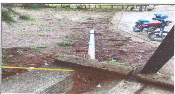
Foto 6: Complemento y mantenimiento de cuneta de concreto.
