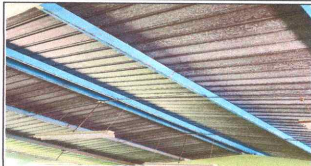
Foto 2: Mantenimiento de estructura metálica lijado y pintado.
