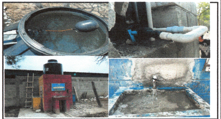
Foto 4: reparacion completo de lavamanos y tinaco de agua
