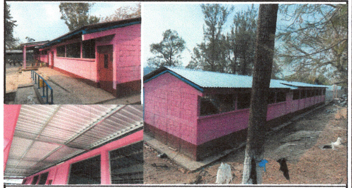
Foto 2: cambio de lamina acanalada a lamina troquelada
