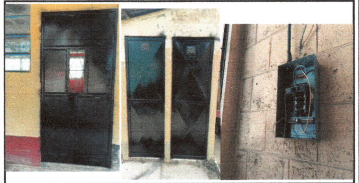
Foto 6: reparación de puertas y sistema electrico
