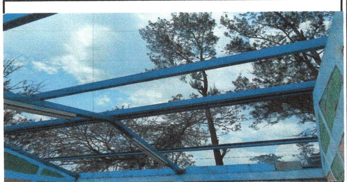
Foto 2: cambio de lamina acanalada a lamina troquelada
