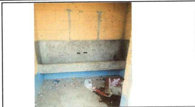
Foto 7: REPARACION Y SUSTITUCION DE AZULEJOS PARA URINALES
