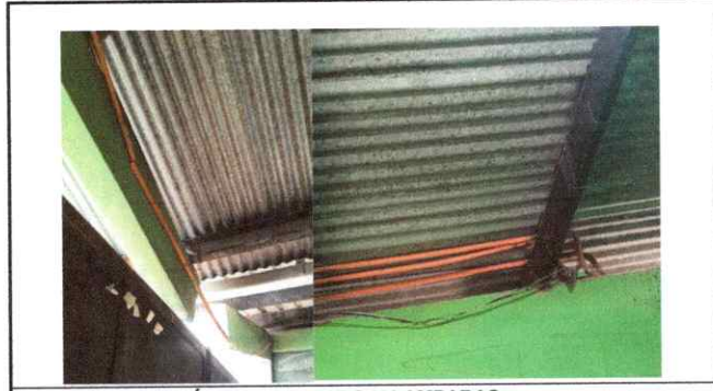
Foto 8: SUSTITUCIÓN DE CABLEADO Y LAMPARAS
