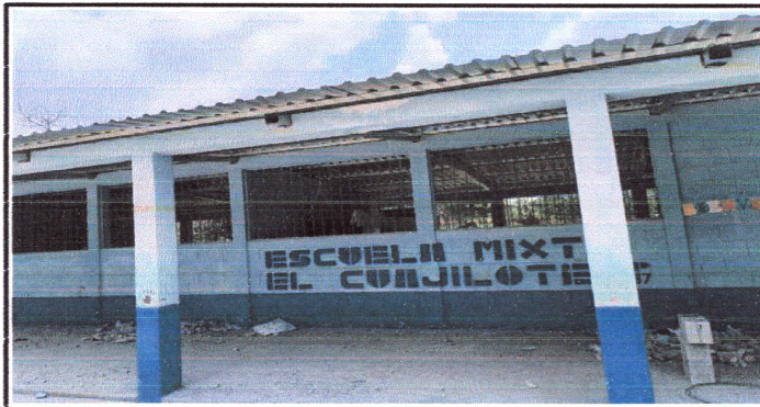
Foto 3: Reparación de techo de modulo 1. Finalizada
