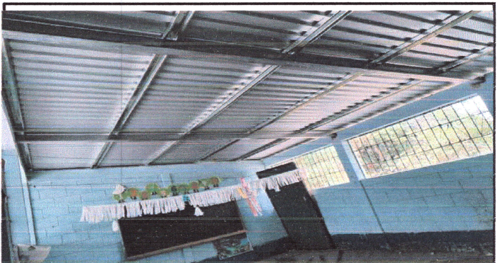
Foto 4: Reparación de techo de modulo 2. Finalizada
