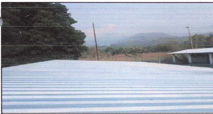
Foto 5: Cubierta de lámina finalizada.
