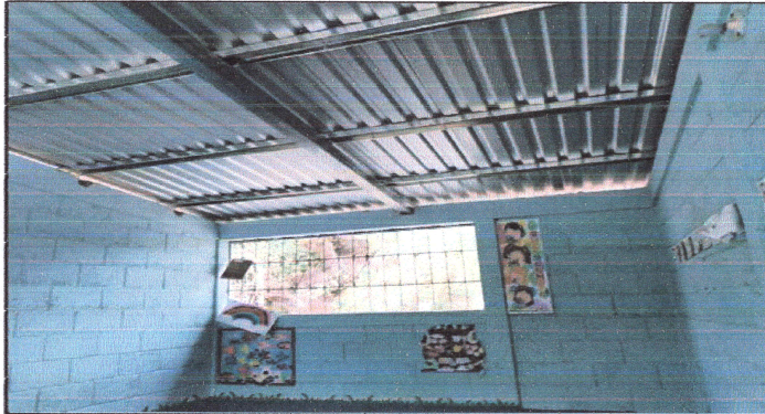
Foto1: Estructura y cubierta de lámina reparada.
