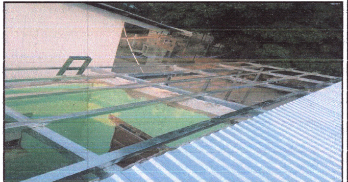
Foto 4: Colocación de nueva estructura metálica.
