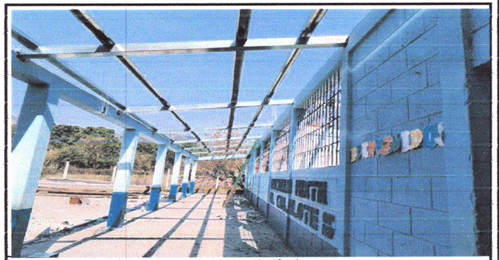
Foto 6: Colocación de nueva cubierta de lámina.
