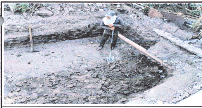
Foto 5: Preparación de terreno para reparación de Fosa Séptica.
