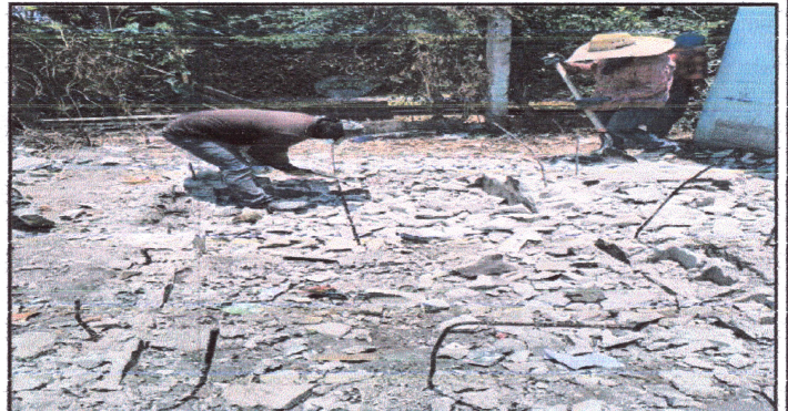
Foto 2: Demolición de Fosa Séptica en mal estado.
