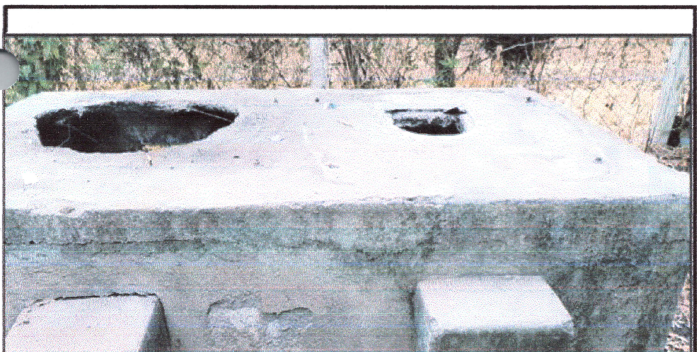
Foto 5: Reparación y mantenimiento de fosa séptica
