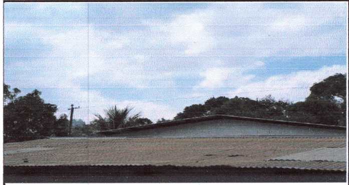
FOTO 2: Sustitución de techo
