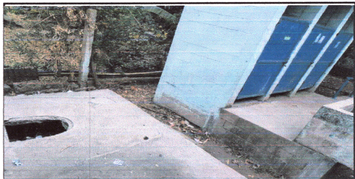
Foto 6: Mejoramiento de drenaje de los sanitarios
