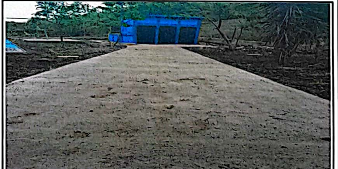
Foto 6: Losa de patio terminada
