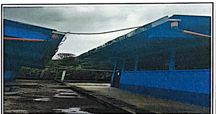
Foto 4: canales y bajadas de agua pluvial
