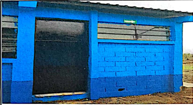
Foto1: Sustrucción de puerta
