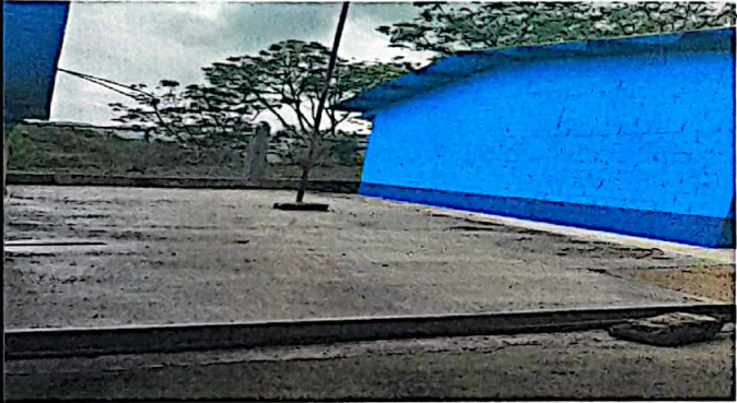
Foto 3: Losa de patio
