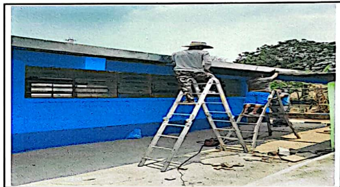
Foto 4: Canales y bajadas de agua
