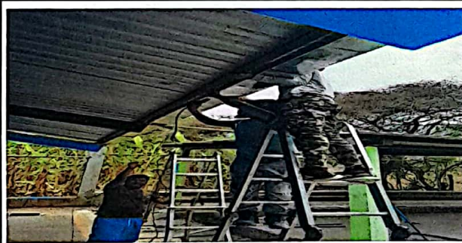
Foto 5: Canales y bajadas de agua.
