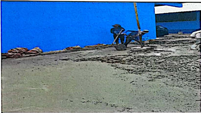
Foto 3: Fundiendo losa de patio.
