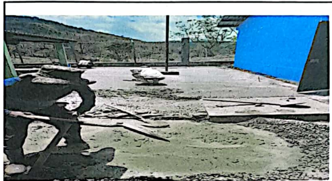
Foto 2: Fundiendo losa de patio
