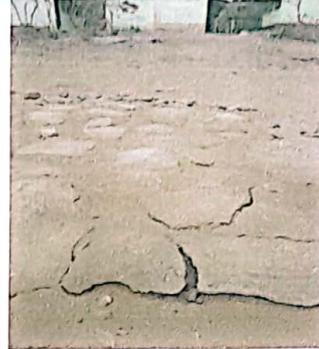
FOTO 2: Losa de patio en mal estado
