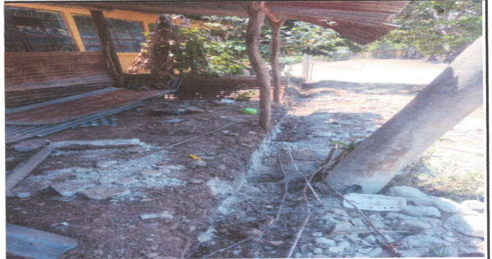
Foto 2: avance de sustitucion de maya y postes
