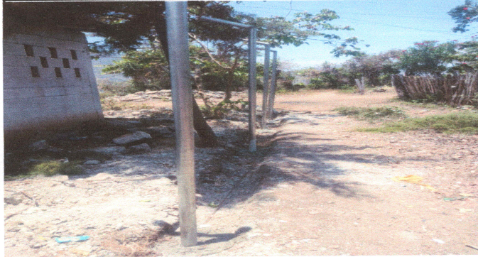
Foto1: avance de cambio de postes
