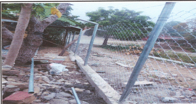
Foto 5: avance en la sustitucion de maya y postes
