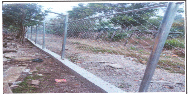
Foto 6: avance de la sustitucion de maya y postes
