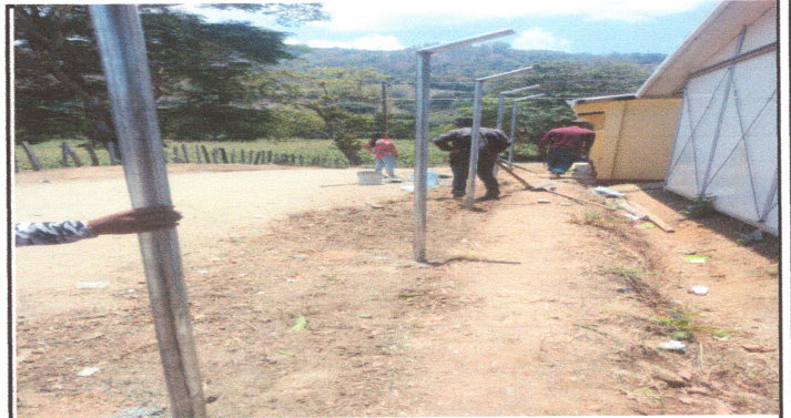
Foto 4: avance en la sustitucion de postes
