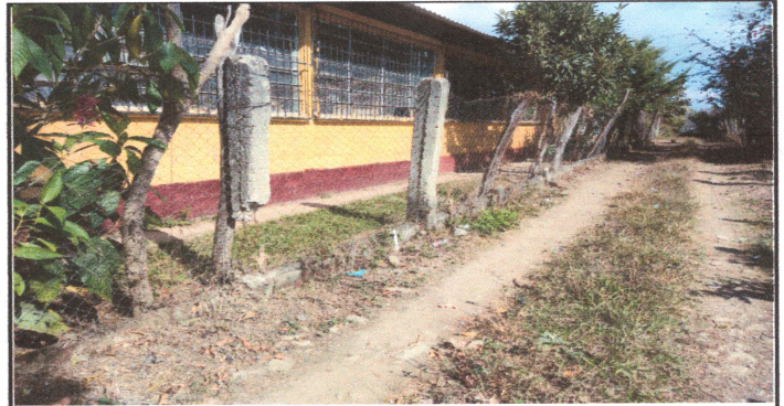
Foto 2: sustitucion de maya trasera
