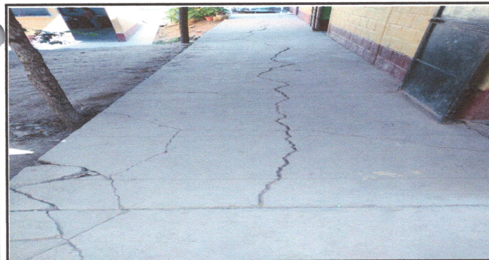
Foto 5: fundicion de losa para patio
