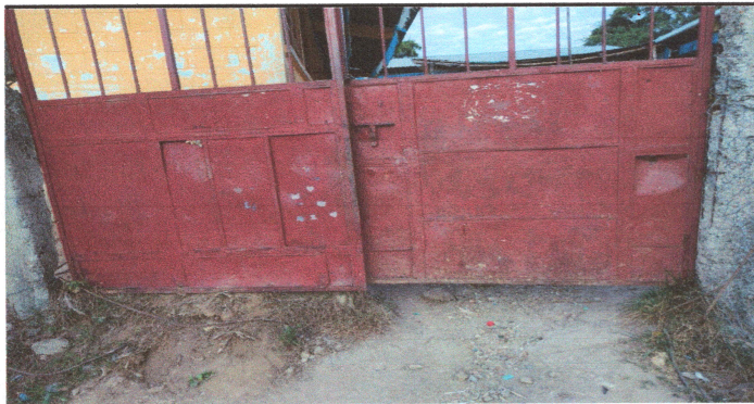
Foto 3: sustitucion de porton
