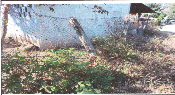
Foto 1: sustitucion de postes
