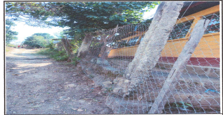
Foto 6: cambio de maya y postes
