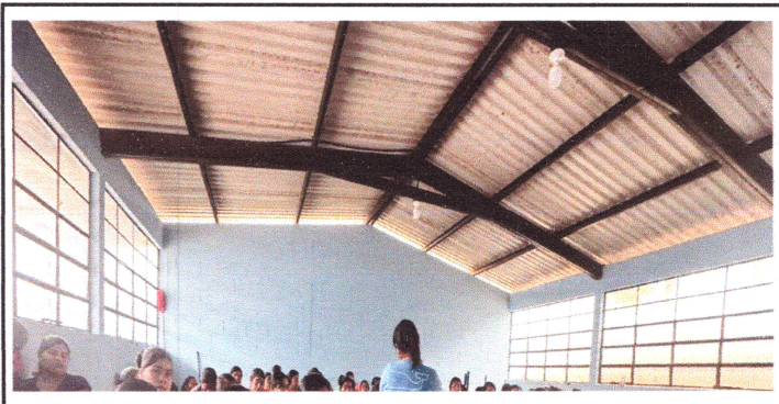
Foto 6: Cambio de techo de lamina y reparacion de sistema electrico Finalizado
