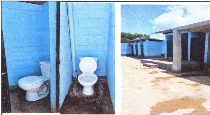
Foto 3: Reparacion de baños Finalizado
