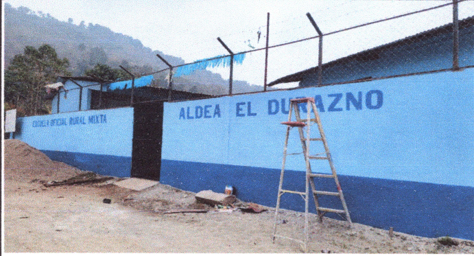
Foto1: Reparacion de la circulacion del establecimiento Finalizado
