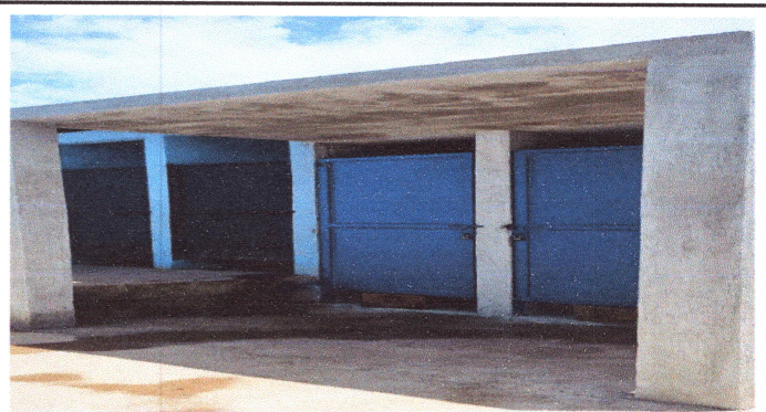
Foto 2: Reparacion de puertas Finalizado
