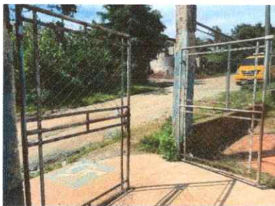
Foto 5: Mantenimiento a Portones
