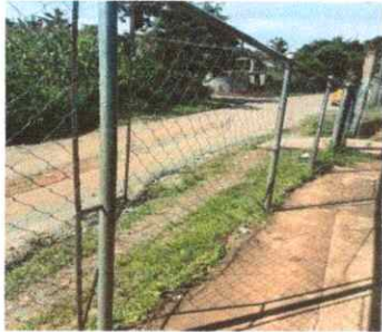
Foto 1: Cerco o muro perimetral
