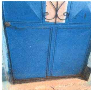
Foto 3: Reparación de puertas
