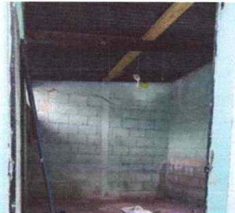
Foto 4: cambio te decho en aula y puesta de piso de granito.
