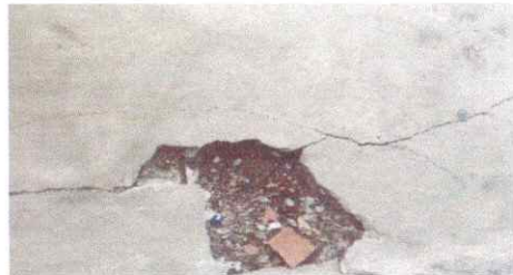
Foto 4: PISO DE CONCRETO AREA DE BAÑOS
