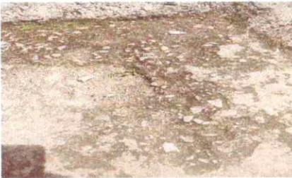
Foto 3: LOSA DE PATIO
