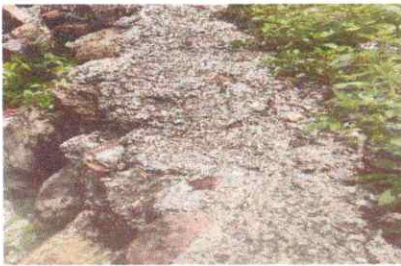
Foto 5: MURO DE CONTENCIÓN
