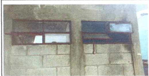
Foto 2: PINTURA EN MUROS DE BAÑOS INTERIOR Y EXTERIOR
