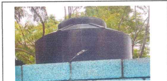
Foto 3: SUSTITUCION DEPOSITO DE AGUA
